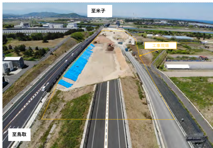
【起点側（東側から撮影）】
