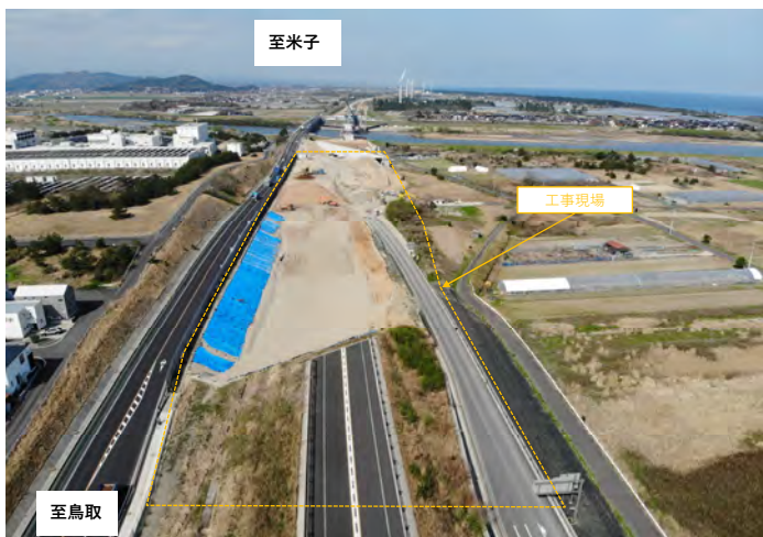
【起点側（東側から撮影）】
