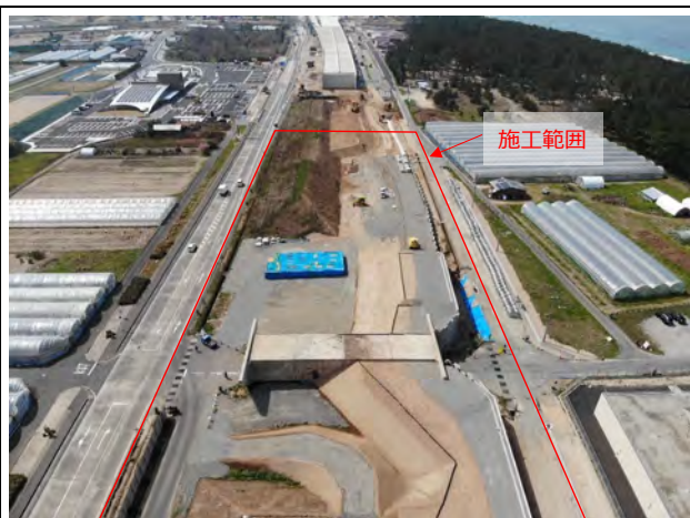
工事現場東側より撮影
