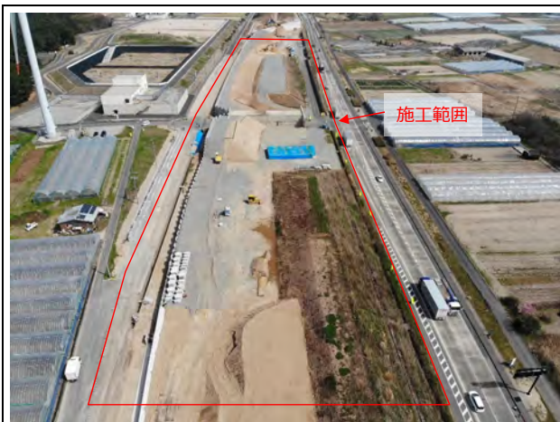
工事現場西側より撮影
