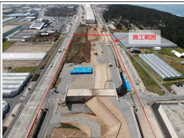
工事現場東側より撮影
