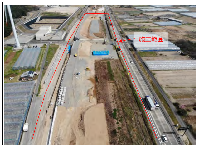
工事現場西側より撮影
