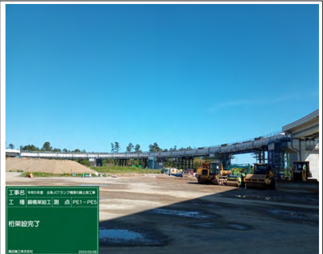
主桁架設状況
