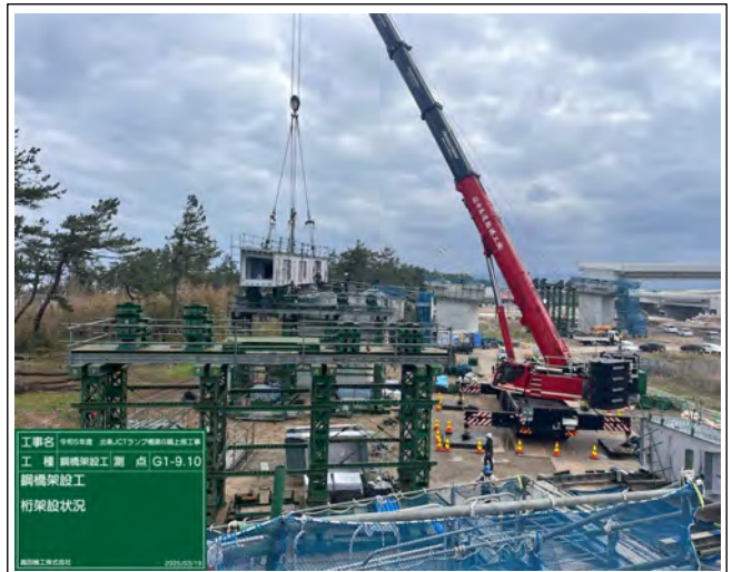
主桁架設状況
