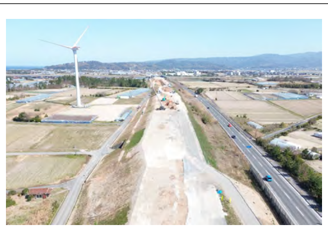
工事現場西側より撮影
