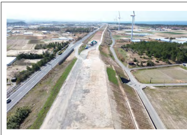
工事現場東側より撮影
