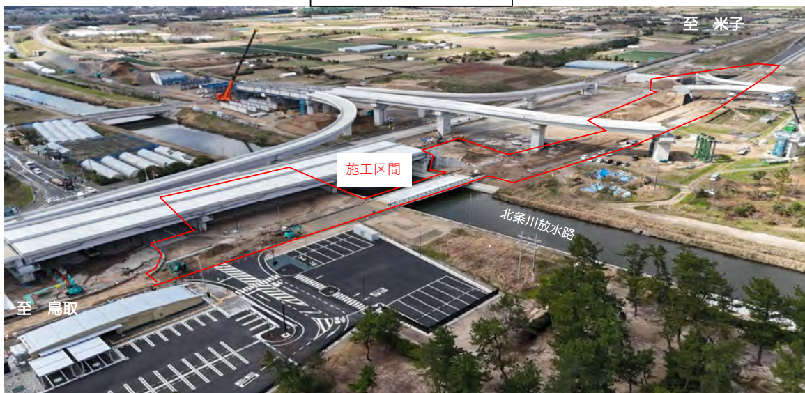
令和7年3月末 進捗状況写真
