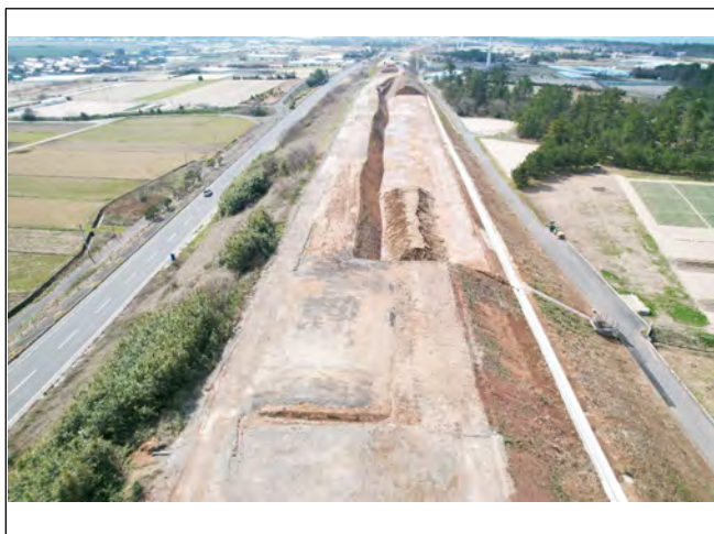
工事現場東側より撮影
