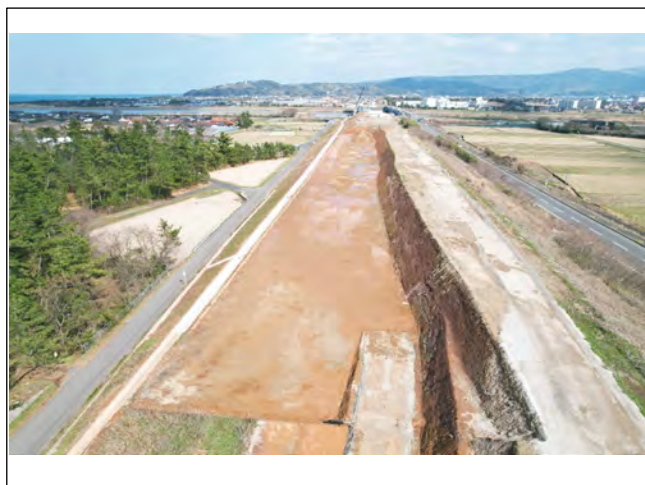
工事現場西側より撮影
