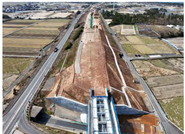
本体工事範囲 東側より
