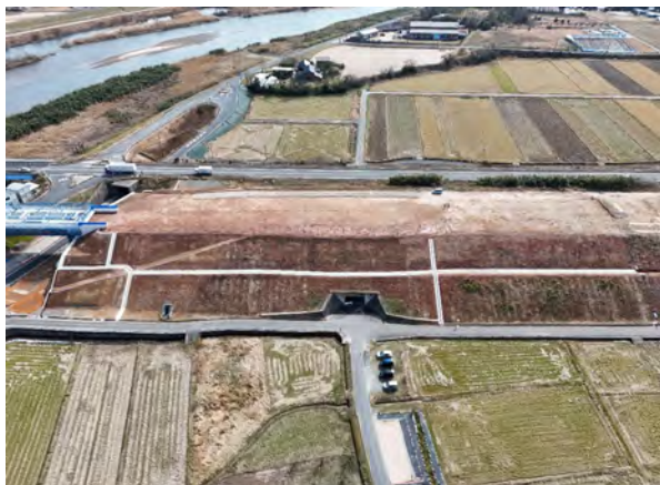
本体工事範囲 北側より
