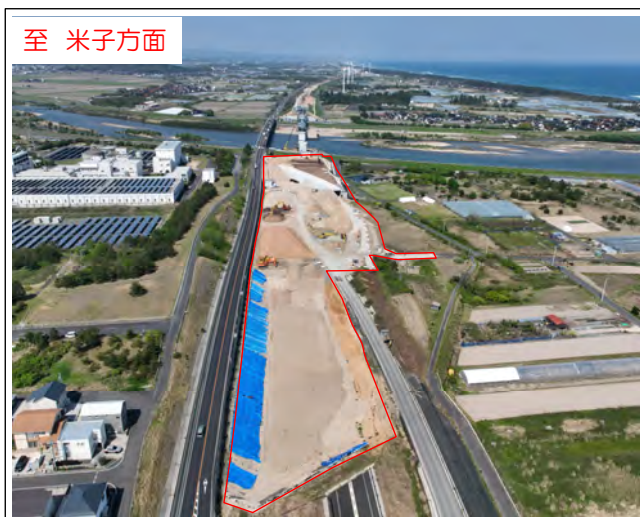
工事現場起点側より撮影
