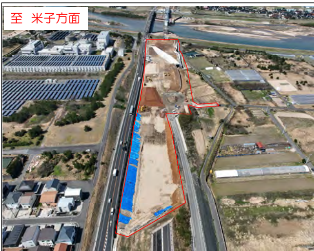
工事現場起点側より撮影
