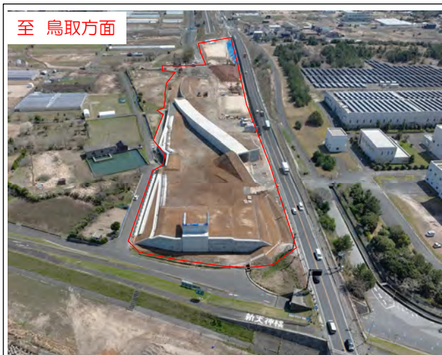
工事現場終点側より撮影
