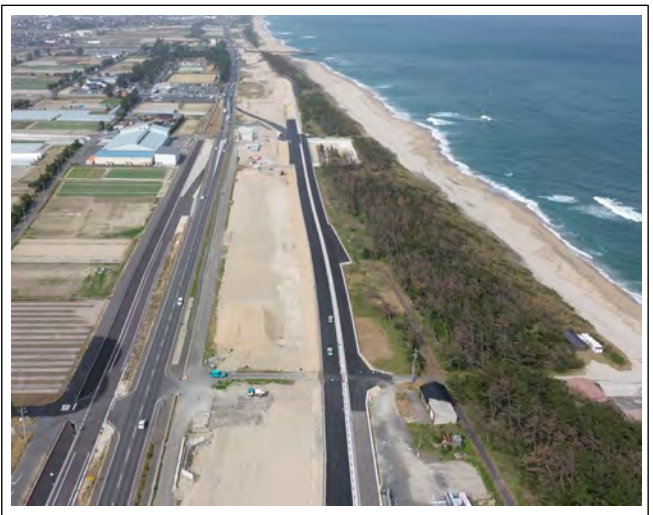
国道9号上り線(東側より撮影)
