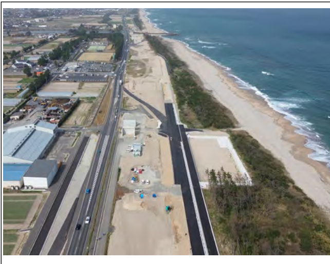
国道9号上り線セパレート接続部(東側より撮影)
