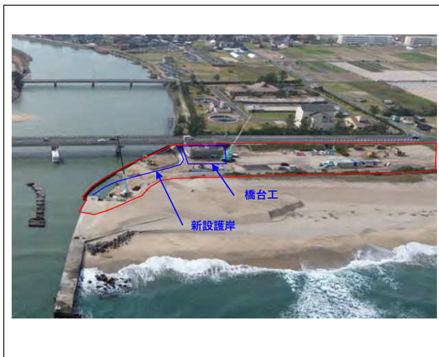
施工箇所（北側から南側撮影）
