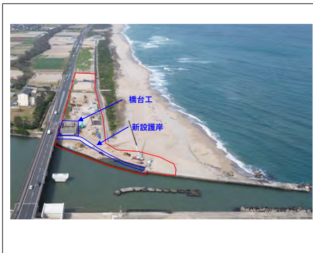
施工箇所（東側から西側撮影）
