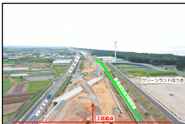
令和7年4月末（起点側より）
