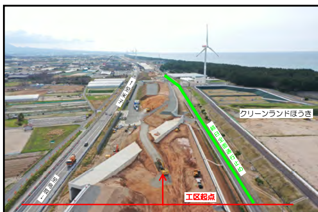
令和7年3月末（起点側より）
