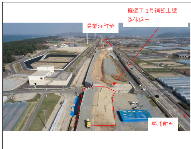
施工完了(国坂)
