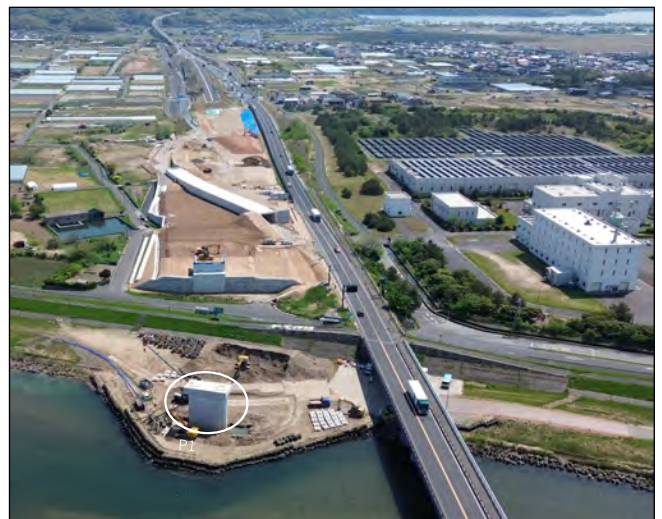
終点側（北栄町江北より）
