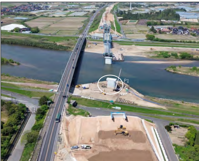
起点側（湯梨浜町はわい長瀬より）
