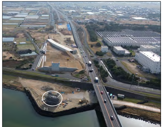
終点側（北栄町江北より）
