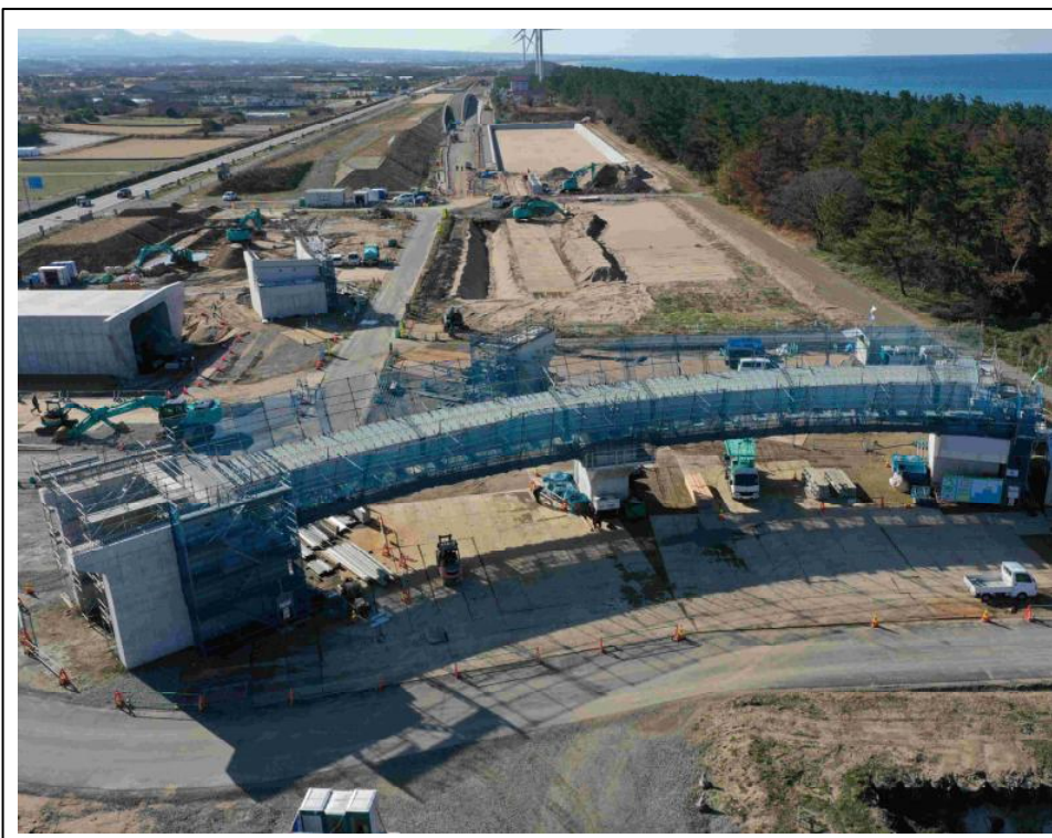
施工状況（令和6年2月9日撮影）
