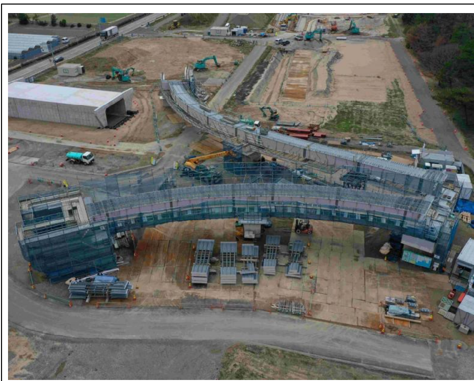
施工状況（令和6年2月27日撮影）
