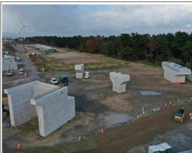
施工状況（令和5年12月20日撮影）
