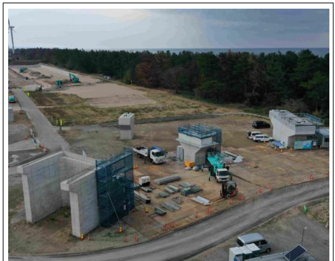
施工状況（令和5年12月27日撮影）
