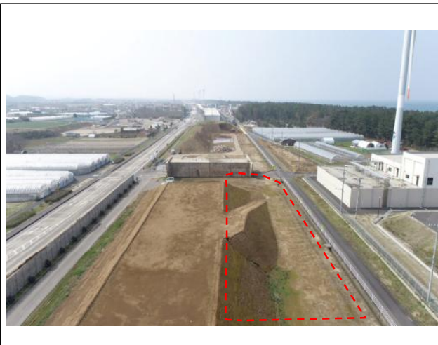
施工状況（国坂）
