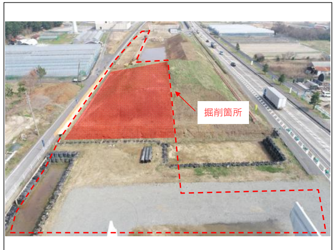
施工状況（国坂）
