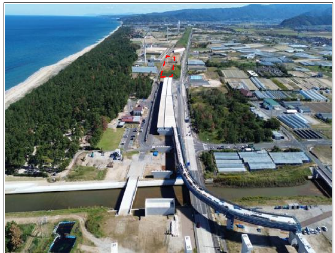
施工状況（国坂）
