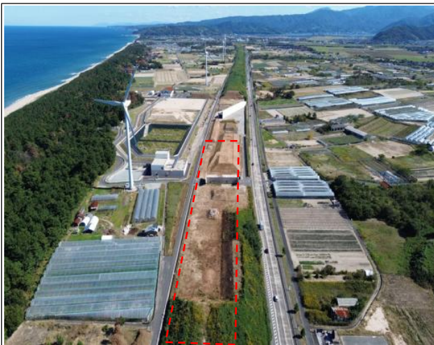
施工状況（国坂）
