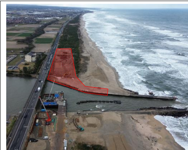
施工箇所（東側から西側撮影）
