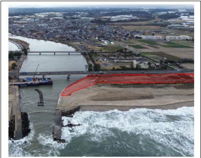
施工箇所（北側から南側撮影）
