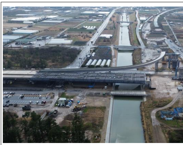
施工状況（海側より）
