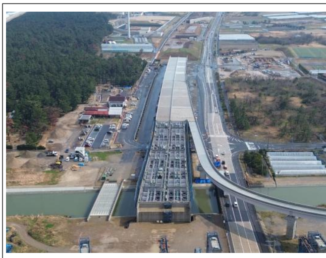
施工状況（米子方面より）
