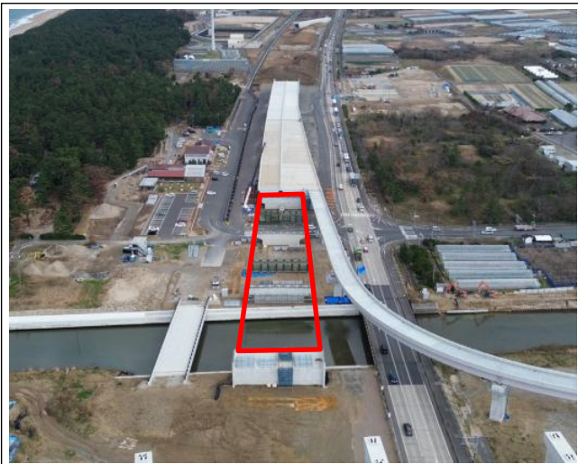
施工状況（米子方面より）
