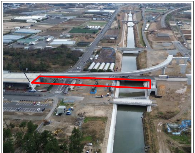
施工状況（海側より）
