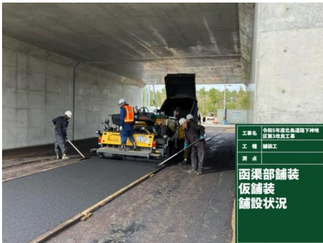
函渠部-舗設状況
