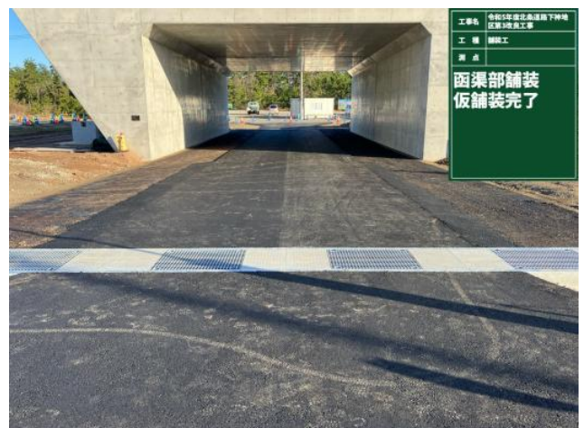
函渠部-舗装完了
