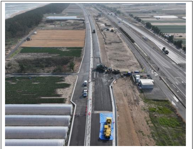
工事施工場所 西側より(北栄町西園)
