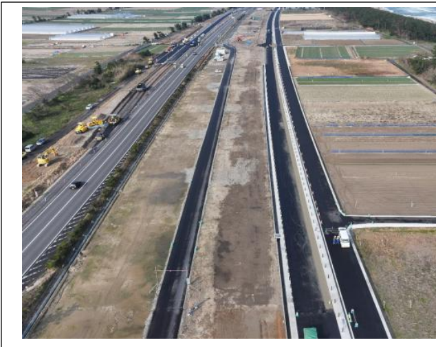
工事施工場所 東側より(北栄町東園)
