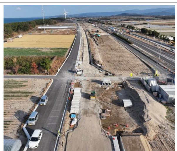
工事施工場所 西側より(北栄町西園)
