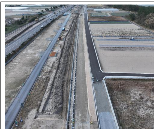
工事施工場所 東側より(北栄町東園)
