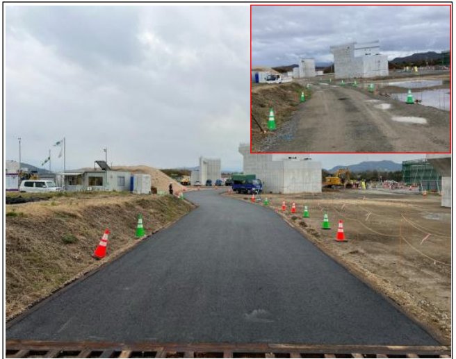
北条JCT工事用道路 舗装工
