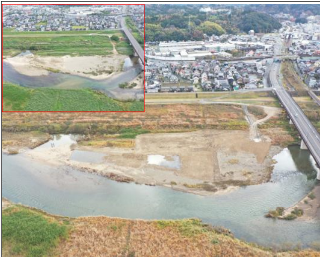
仮設盛土材掘削完了(倉吉市天神町)
