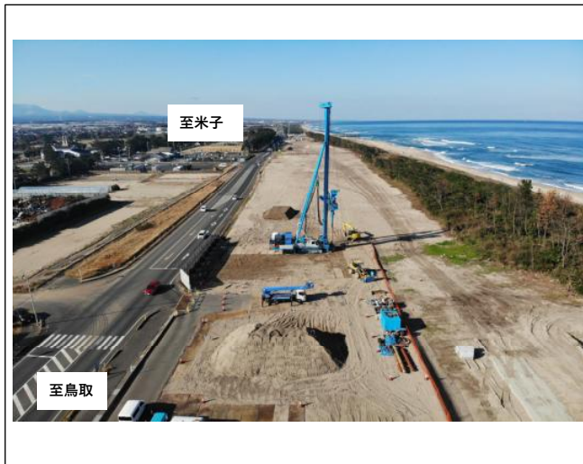
橋台施工箇所 全景（東側より西側を望む）
