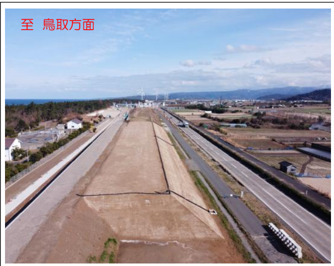
工事現場終点側より撮影
