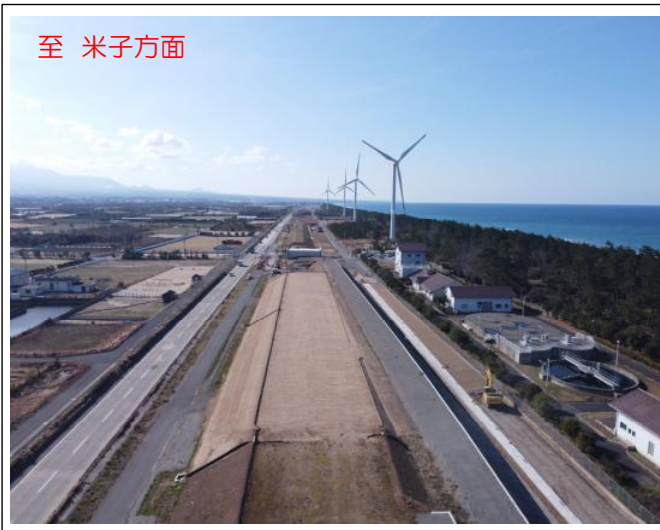
工事現場起点側より撮影
