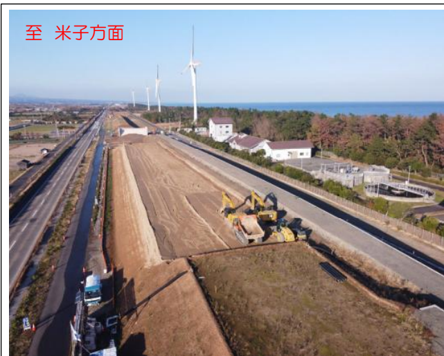
工事現場起点側より撮影
