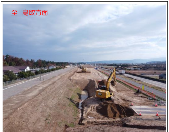
工事現場終点側より撮影
