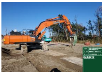
5.17mの深さをセメントミルクで攪拌混合。
