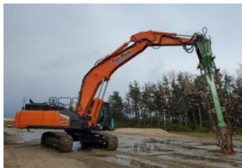
中層混合処理の施工
