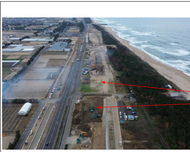
1月予定箇所（西～東側）
