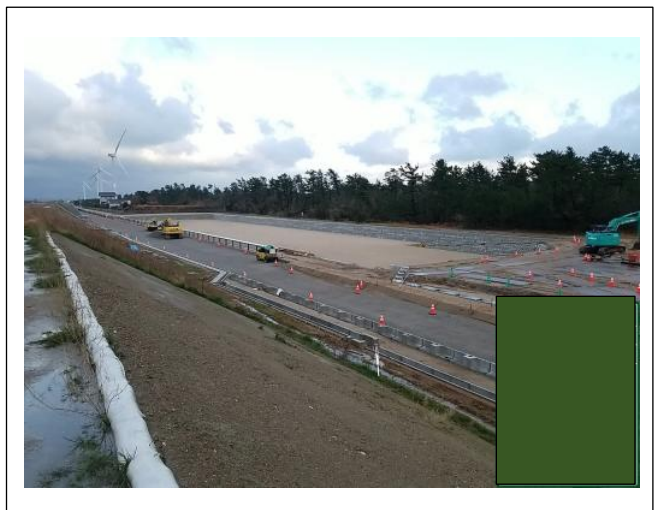
施工場所（東側より）
