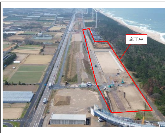
施工場所（東側より）
