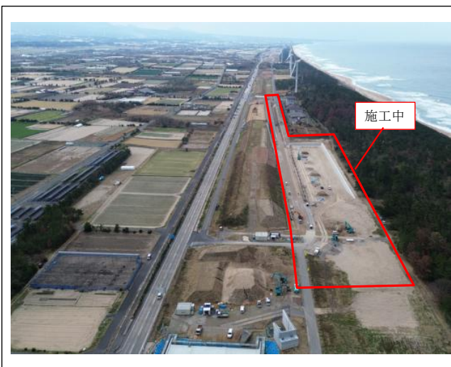
施工場所（東側より）
