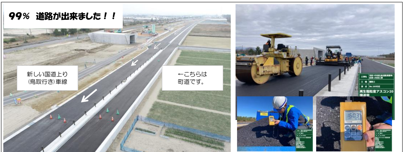
作業範囲の全景（ドローンにて）
