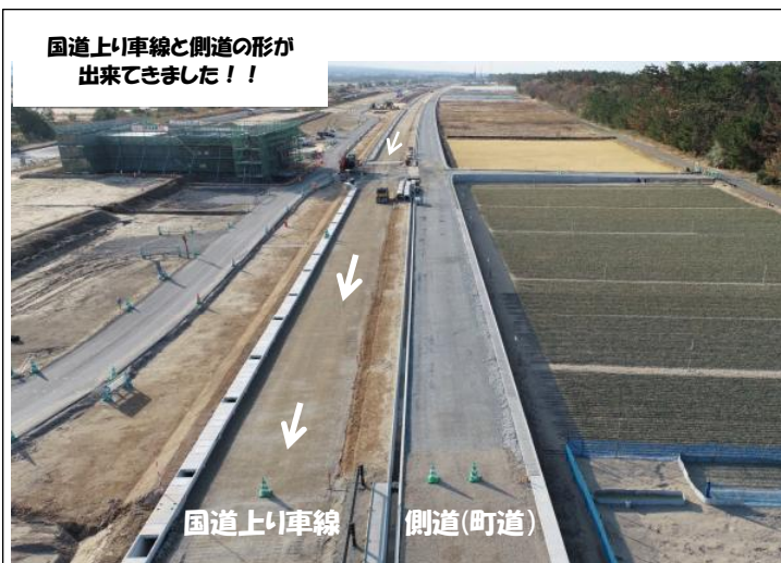
作業範囲の全景（ドローンにて）
