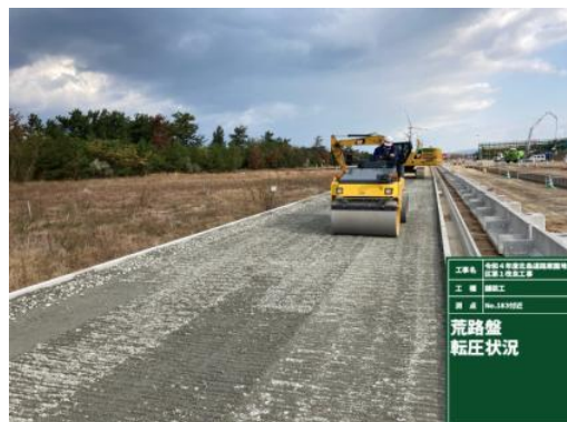
側道の路盤が始まりました！！
