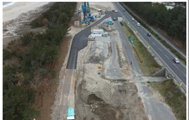
施工状況（1号現場打函渠）
