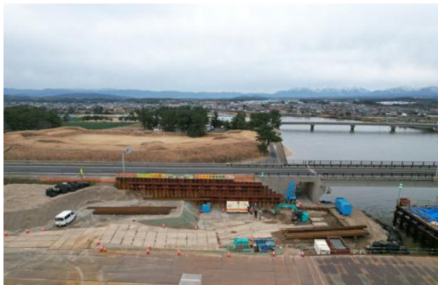
施工状況（A1橋台）
