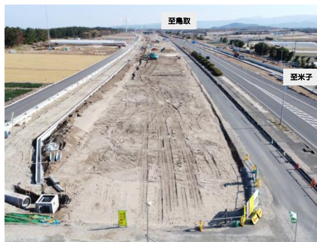
終点側から起点側望む
