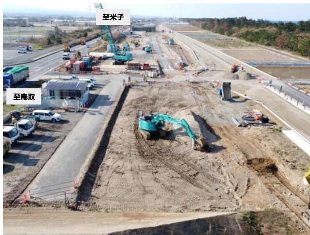
起点側から終点側望む
