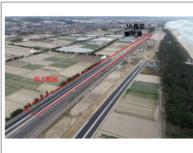
施工箇所 (北栄町西園) 東側より(前半)
