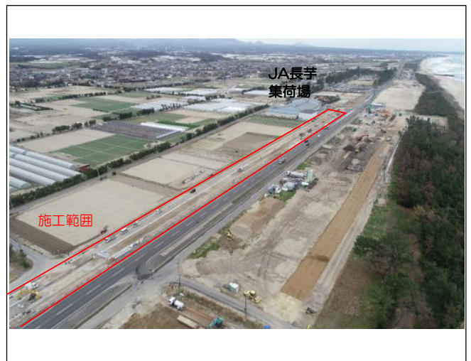
施工箇所 (北栄町西園) 東側より(後半)
