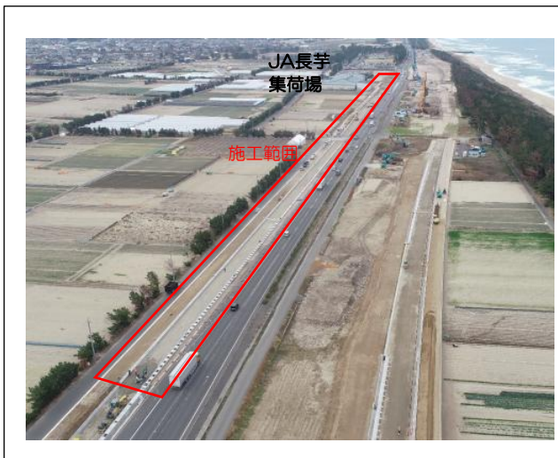
施工箇所 (北栄町西園) 東側より(前半)
