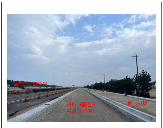
施工箇所 (北栄町西園) 起点側
