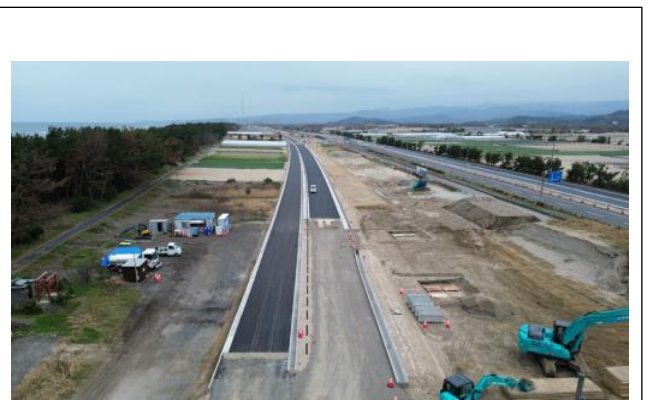
工事現場西側より撮影
