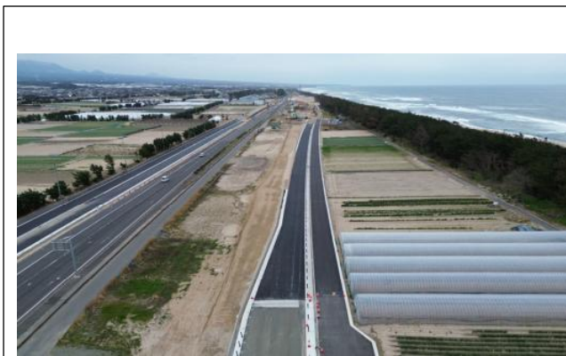
工事現場東側より撮影
