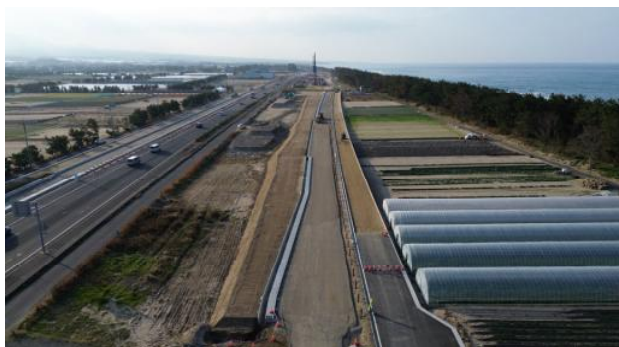
工事現場東側より撮影
