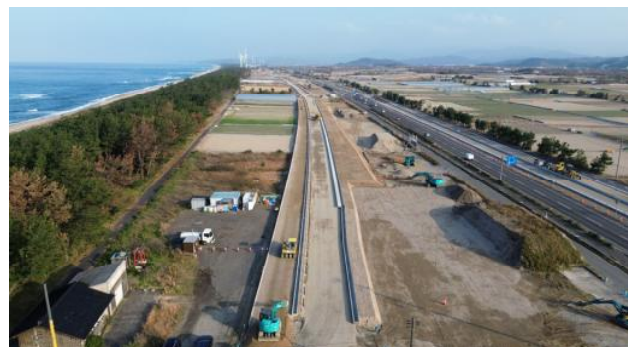
工事現場西側より撮影
