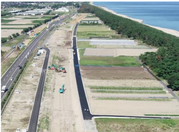
工事施工箇所（北栄町東園）東側より
