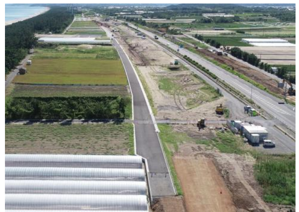
工事施工箇所（北栄町西園）西側より
