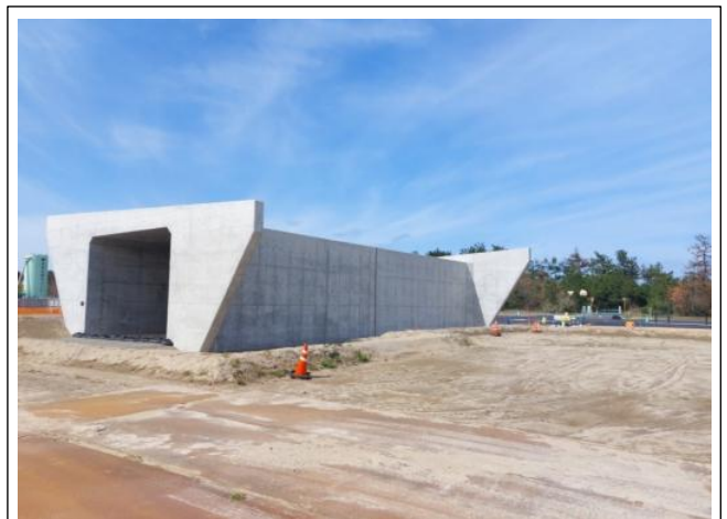
施工状況（東園地区）
