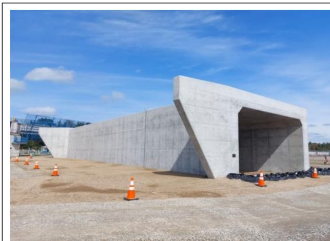
施工状況（弓原地区）
