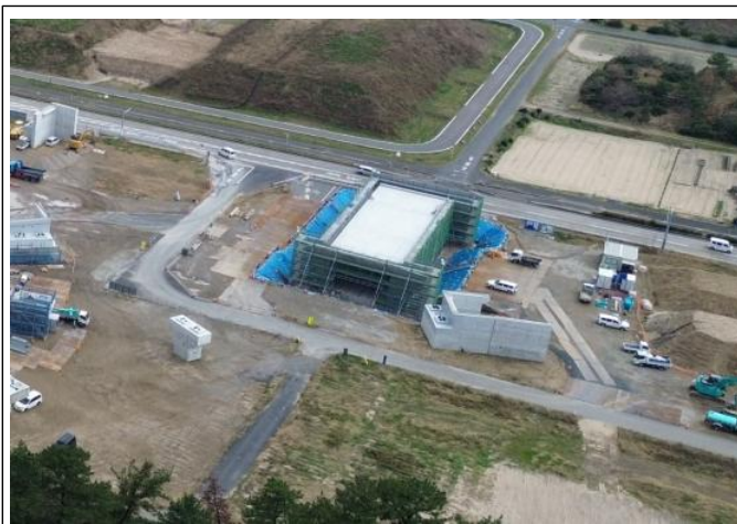
施工状況（弓原地区）
