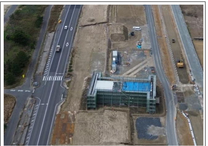
施工状況（東園地区）
