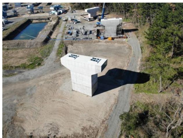
橋脚施工状況 (PE4橋脚)
