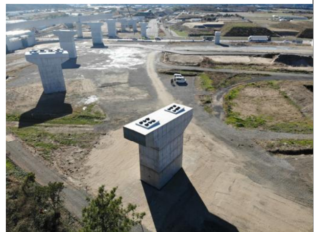
橋脚施工状況 (PE4橋脚)
