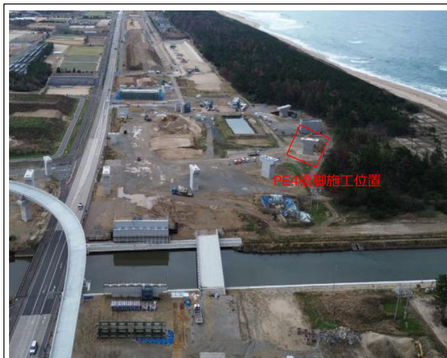
橋脚施工箇所 (PE4橋脚)
