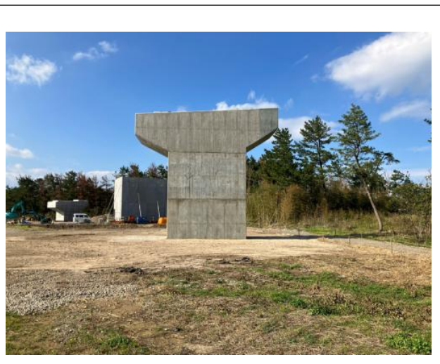
橋脚躯体施工状況(PE4橋脚)
